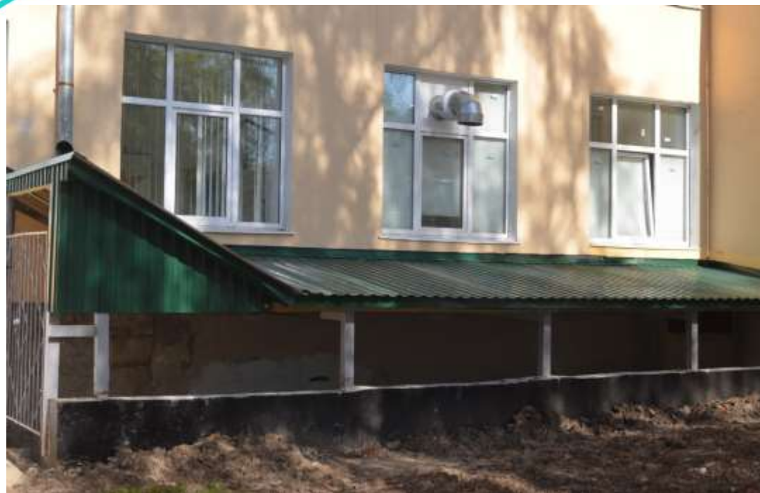
Морфологический корпус ремонт подпорной стены
