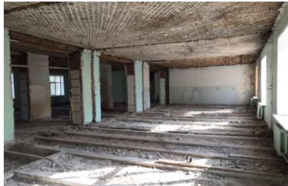
Корпус ул. Есенина демонтажные работы
